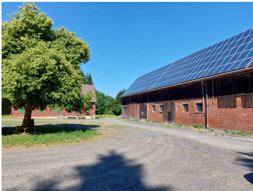
Abbildung 1.7: MOB2 verstärkt das Cluster 4 „Südwestthüringen“ bei Tann ab 02.07.2025.
