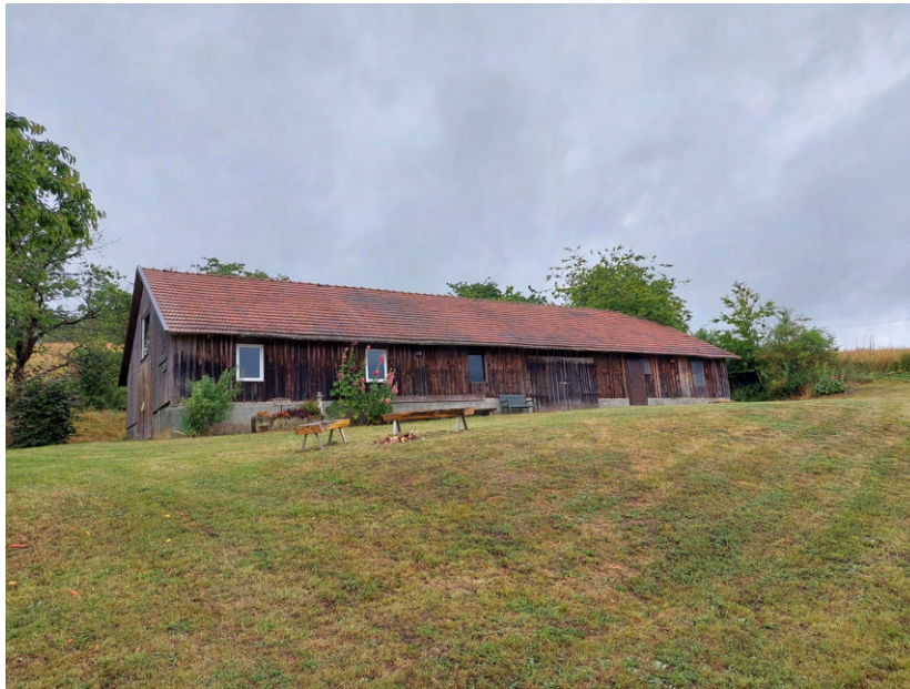
Abbildung 1.6: MOB6 bei Kaltenwestheim verstärkt ab 08.09.2025 das Cluster 4 „Südwestthüringen“ und wird autark mit Strom versorgt.
