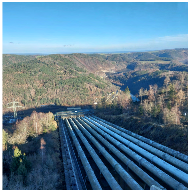
Abbildung 1.5: Blick vom Oberbecken der Talsperre Hohenwarte.
