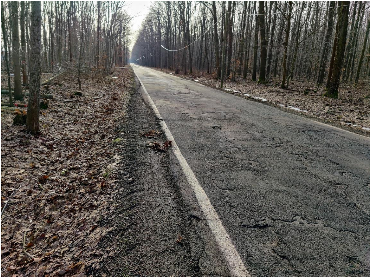
Abb. 2: Abschnitt der K227 südöstlich Panna - hier dürfte sowohl die Planung als auch der Bau einer stationären Anlage kaum Probleme bereiten. (Aufn. 23.02.2021, F. Serfling)
