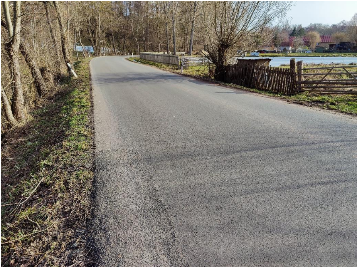
Abb. 17: K207 nordöstlicher Ortsrand Thalbürgel: Blick auf Teilbereiche der Querungsstelle mit abschnittsweise beengten räumlichen Verhältnissen. (Aufn. 23.02.2021, F. Serfling)
