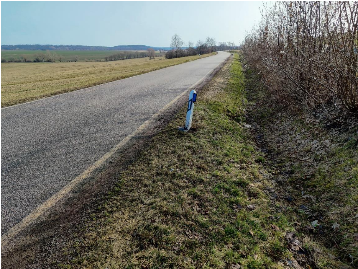
Abb. 21: L1025 zwischen Schnepfenthal und Ernstroda: Planung und Bau einer stationären Amphibien-schutzanlage sind hier weitgehend unproblematisch. (Aufn. 24.02.2021, F. Serfling)
