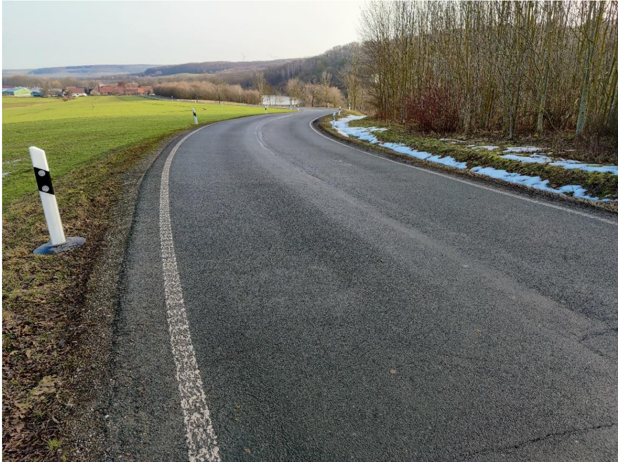
Abb. 12: Blick über den mit einer stationären Anlage zu schützenden Straßenabschnitt der L1060 südlich der Ortschaft Lossnitz. Planung und Bau werden als unproblematisch eingeschätzt, jedoch sind aufgrund der Länge hohe Kosten zu erwarten. (Aufn. 24.02.2021, F. Serfling)
