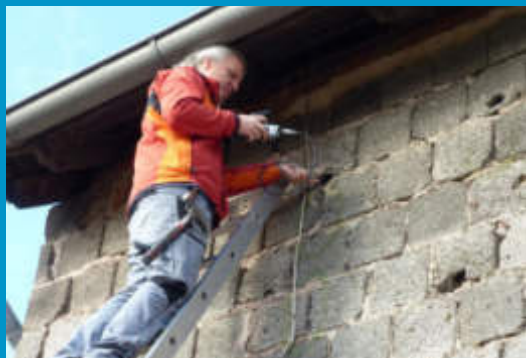
Kontrolle von Hohlblocksteinkammern auf Fledermausbesatz mit Hilfe eines Videoendoskops im Zuge der ökologischen Baubegleitung vor dem Abbruch des Gebäudekomplexes der ehemaligen Gaststätte „Sonne“ in Witzelroda (Wartburgkreis), s. Beitrag von Jörg Klingelhöfer, Inken Karst, Wigbert Schorcht & Martin Biedermann. (Aufn. NACTaktiv / M. Biedermann 04.11.2020)
