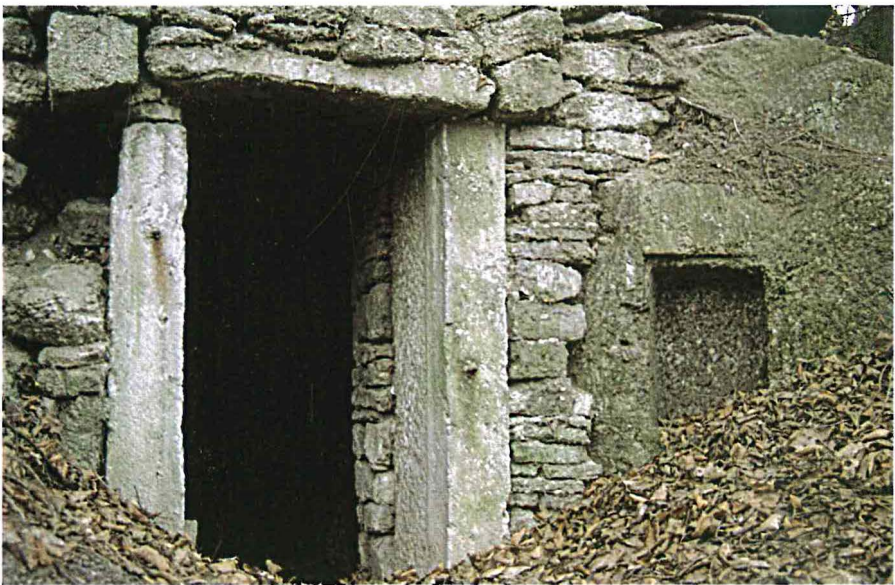
Abb. 76: Eingang zu einem Erdkeller in Löberschütz, Saale-Holzland-Kreis. (Aufn. H.-J. PETZOLD)
