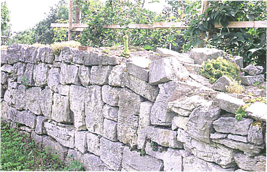
Abb. 72: Natursteinmauer aus trocken gesetzten Kalkblöcken in Branchewinda. (Aufn. TH. SCHIKORA)
