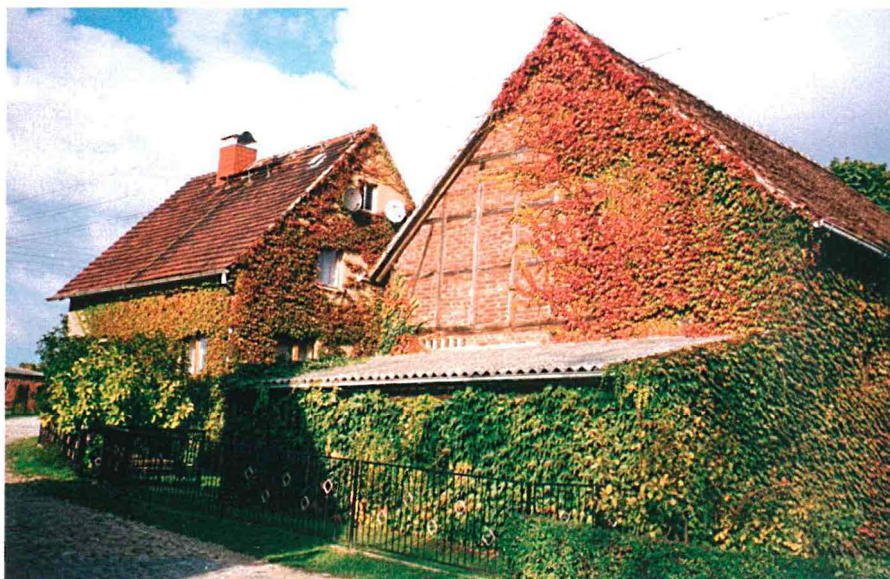
Abb 73: Wilder Wein ( Parthenocissus inserta ) als Fassadenbegrünung an einem Bauernhof in Droschka, Saale-Holzland-Kreis. (Aufn. S. SERFLING)
