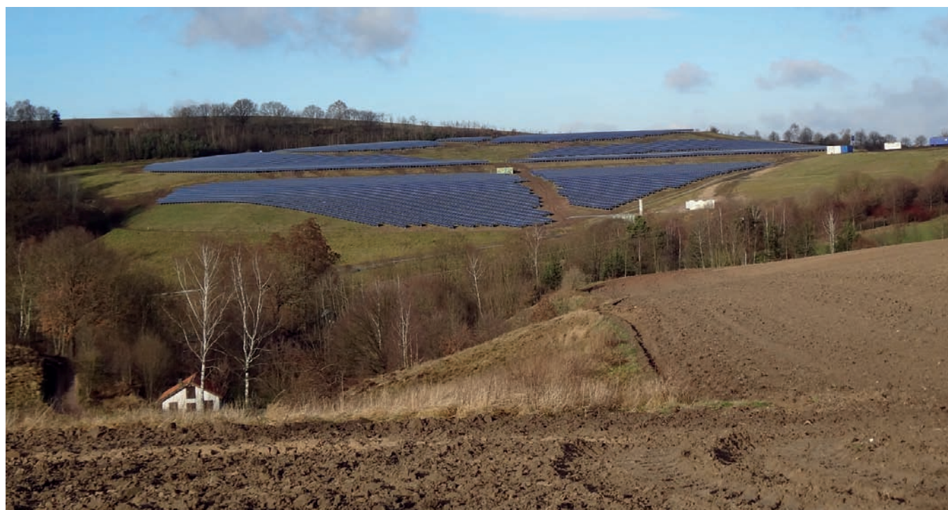
Abb. 10: Photovoltaikanlage auf der Deponie Kloster-Allendorf (Wartburgkreis)
