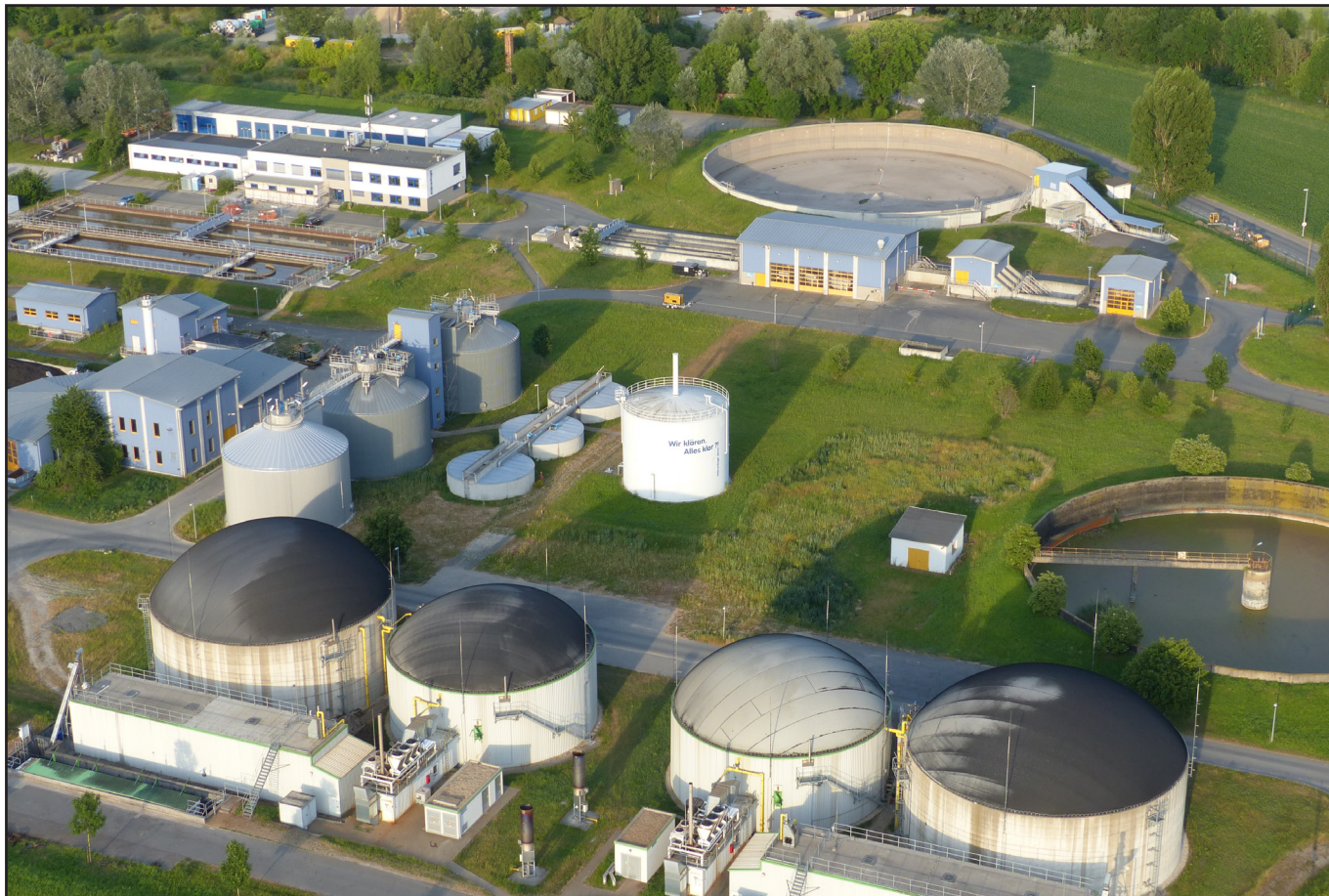
Abb. 13: Kläranlage Jena-Zwätzen (Foto: Karin Hanemann, 06/ 2014)
