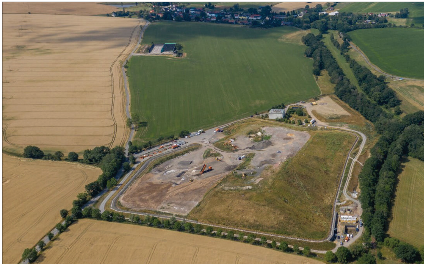
Abb. 9: Ertüchtigte DK II Deponie Krölpa-Chursdorf bei Auma (Foto: AWW Ostthüringen, Gera)
