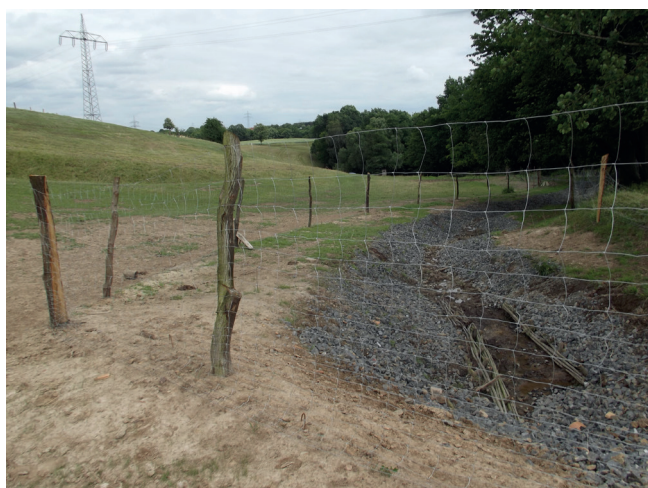
Foto 31: flächiger Schutz ingenieurb biologischer Bauweisen durch einen Wildzaun (Foto: A. Stowasser)
