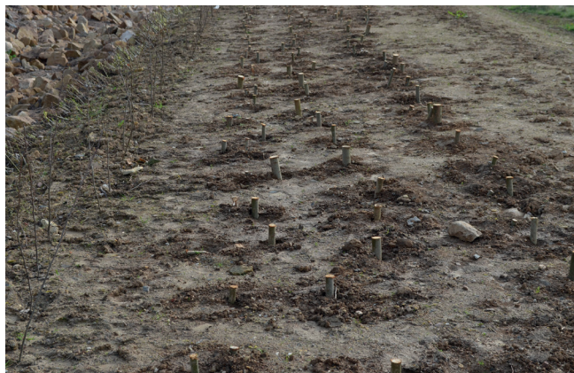
Foto 23: Gehölzanlage durch Einbau von Steckhölzern nach Baufertigstellung (Foto: A. Stowasser)
