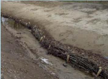
Ingenieurblogische Bauweisen zur Ufersicherung
