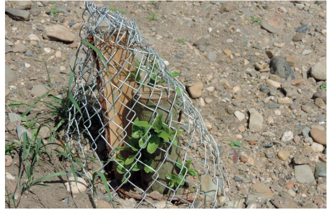
Foto 33: Zum Schutz vor dem Biber können auch Setzstangen und andere ingenieurblogische Bauweisen mit Drahtgeflecht umhüllt werden. (Foto: A. Stowasser)
