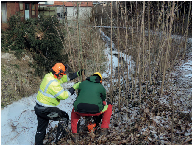
Foto 56: Um stabile Stockastriebe zu entwickeln, muss der Rückschnitt möglichst nah an der Böschung erfolgen. (Foto: A. Stowasser).
