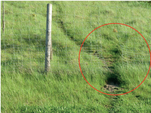
Foto 38: Schadstelle im Wildschutzzäun durch Wildwechsel — Wildzäune sind regelmäßig auf Schadstellen zu prüfen, um Schäden an der Pflanzung zu vermeiden. (Foto: A. Stowasser)
