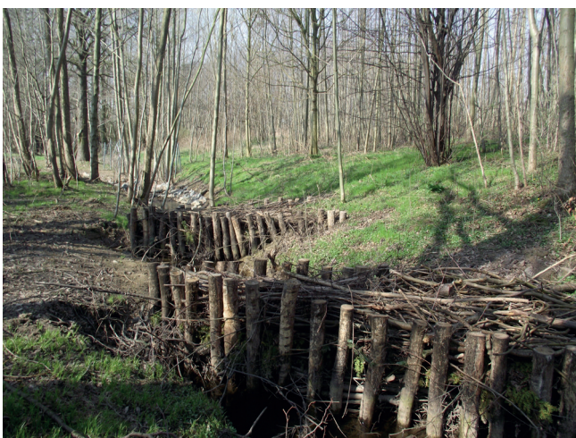
Foto 101: Soll Totholz vor Ort oder an anderer Stelle fixiert werden, sind Totholzbuhnen eine Möglichkeit der Fixierung des Materials. (Foto: A. Stowasser)
