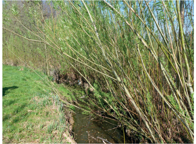
Foto 2: Aus den Lebendfaschinen bildet sich ein Weidensaum entlang des Gewässers. (Foto: A. Stowasser)
