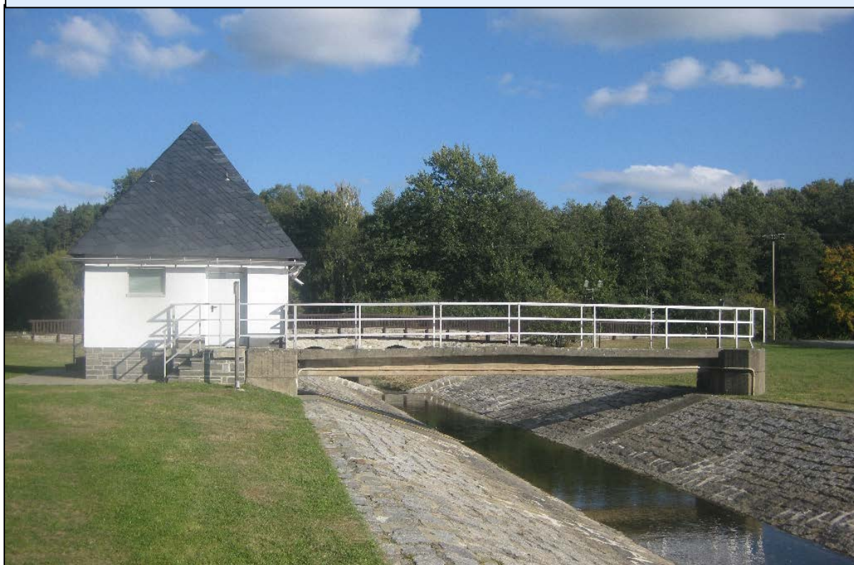
Pegel Läßig/Weida – Zulaufpegel der Talsperre Zeulenroda (Foto: TLUG, Okt. 2012)
