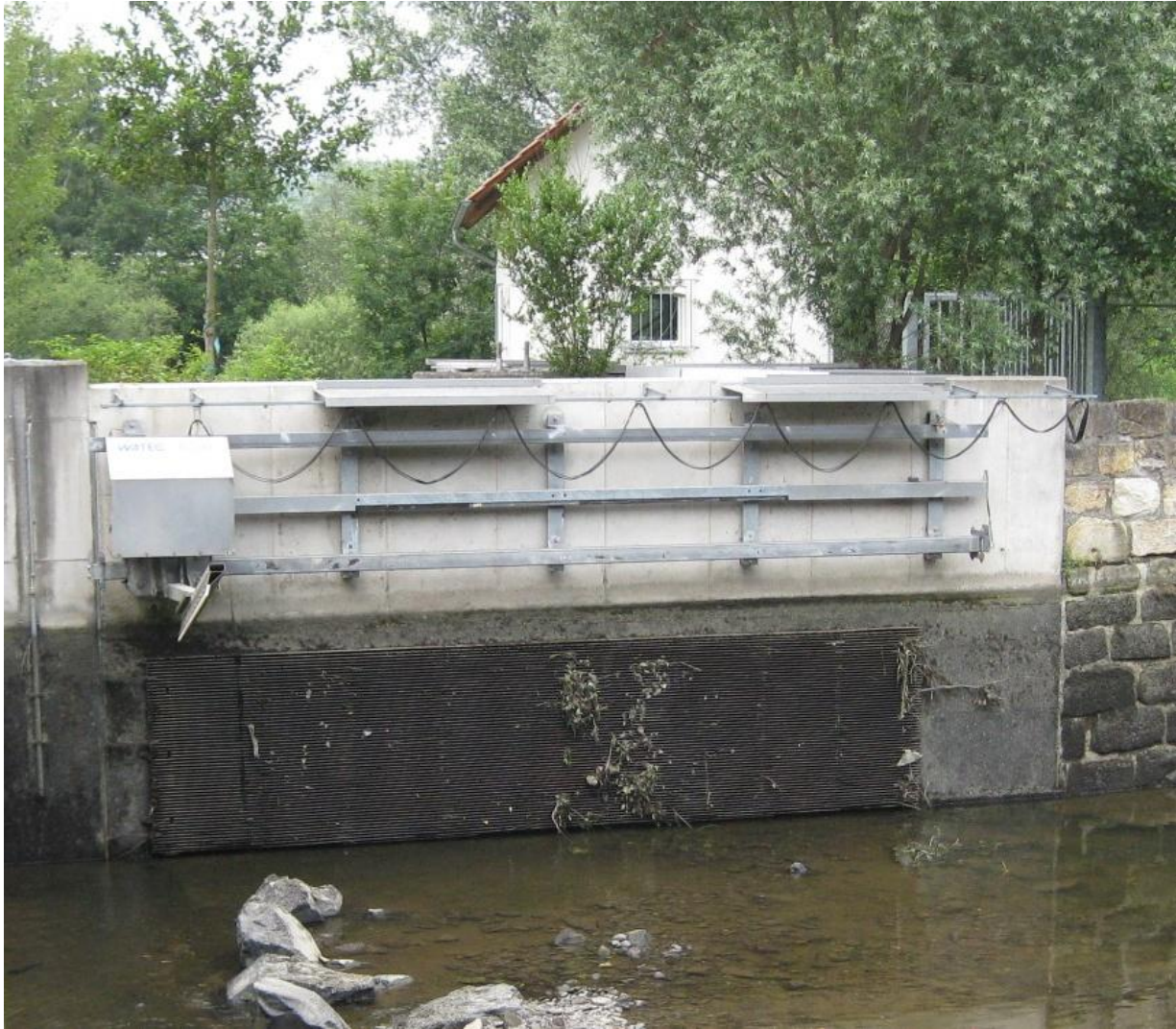
Abbildung 10: Horizontalrechen an der Rest-WKA Unterpreilipp bei abgesenktem Wasserstand
