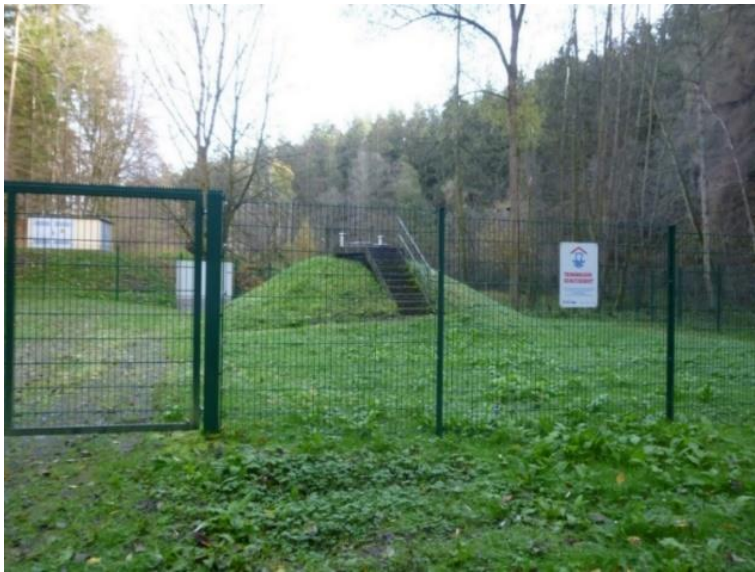
Abbildung 1: Brunnenfassung, ordnungsgemäß eingezäunt und beschildert
