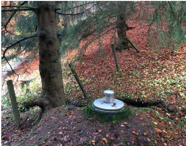
Abbildung 6: WGA mit Baum im unmittelbaren Fassungsbereich
