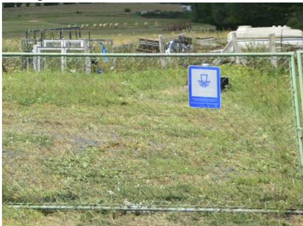
Abbildung 8: Lagerung von Bauabfällen an Grenze zur Schutzzone I
