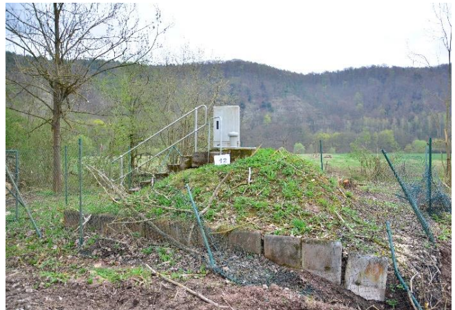
Abbildung 3: WGA mit eingestürzter Einzäunung
