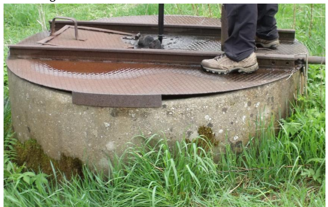
Abbildung 14: WGA mit unzureichender Abdeckung
